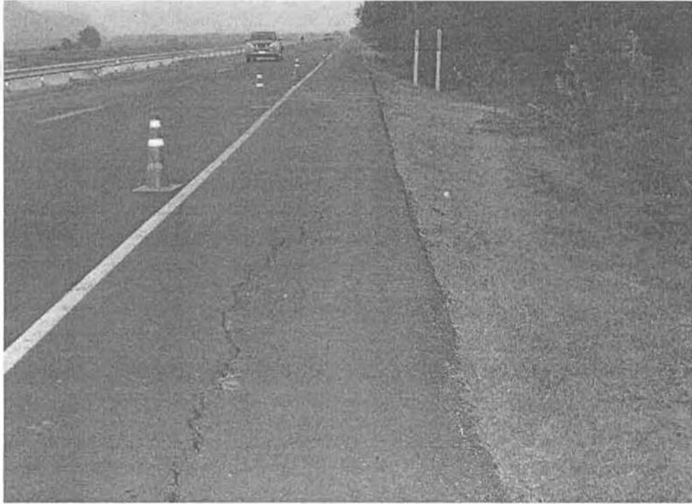
รูปที่ 3.11 ทางหลวงหมายเลข 3196 (อ.บ้านหมี่ จ.ลพบุรี) ระหว่างกม.55+000 – กม.55+100
